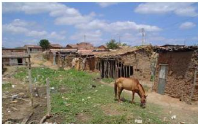
Figura 23 – Casas de taipa no Sumaré
