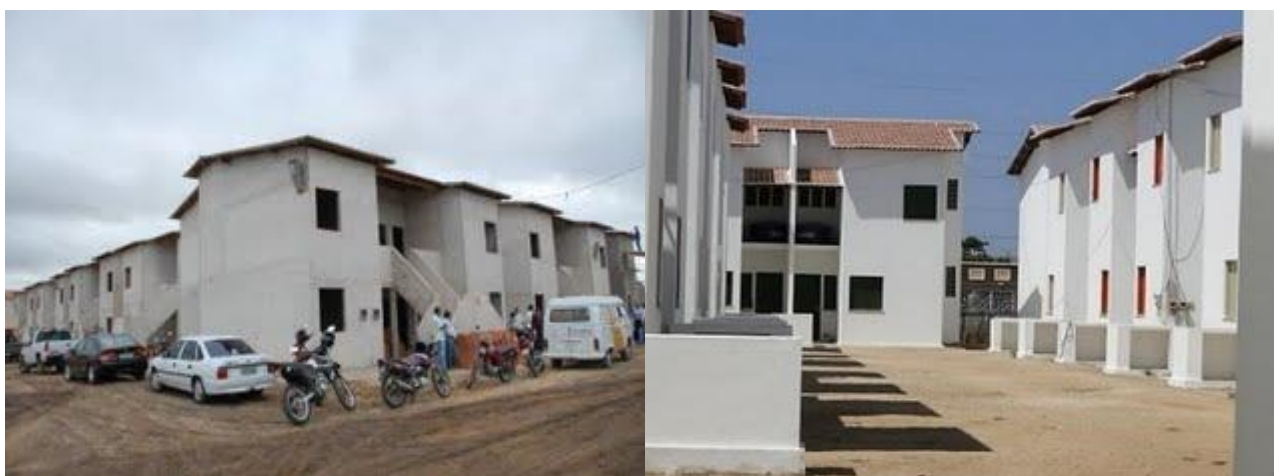
Figura 22 – Projeto Parque Mucambinho - Concluído
